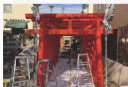
鳥居修繕・塗替
