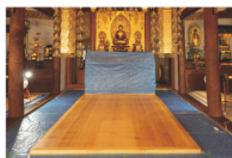
寺院床・壁面塗装
